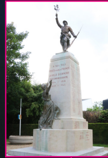
Rénovation du Monument aux morts
