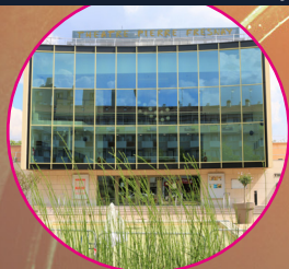
Nouvelle façade vitrée du Théâtre Pierre-Fresnay
