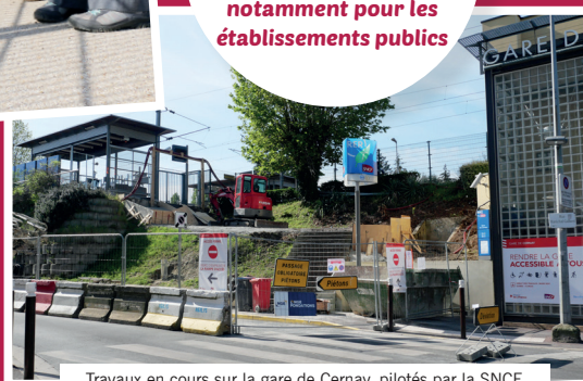
Travaux en cours sur la gare de Cernay, pilotés par la SNCF, la Région Île-de-France et Île-de-France Mobilités.
